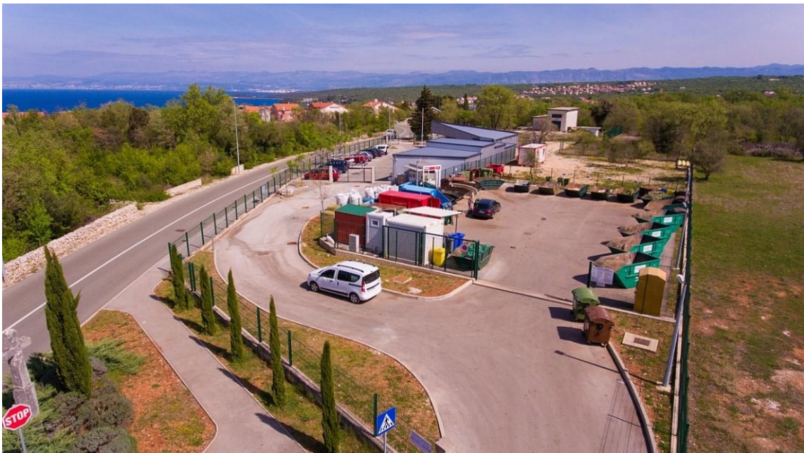
Slika 3.: Uređeno reciklažno dvorište Malinska
