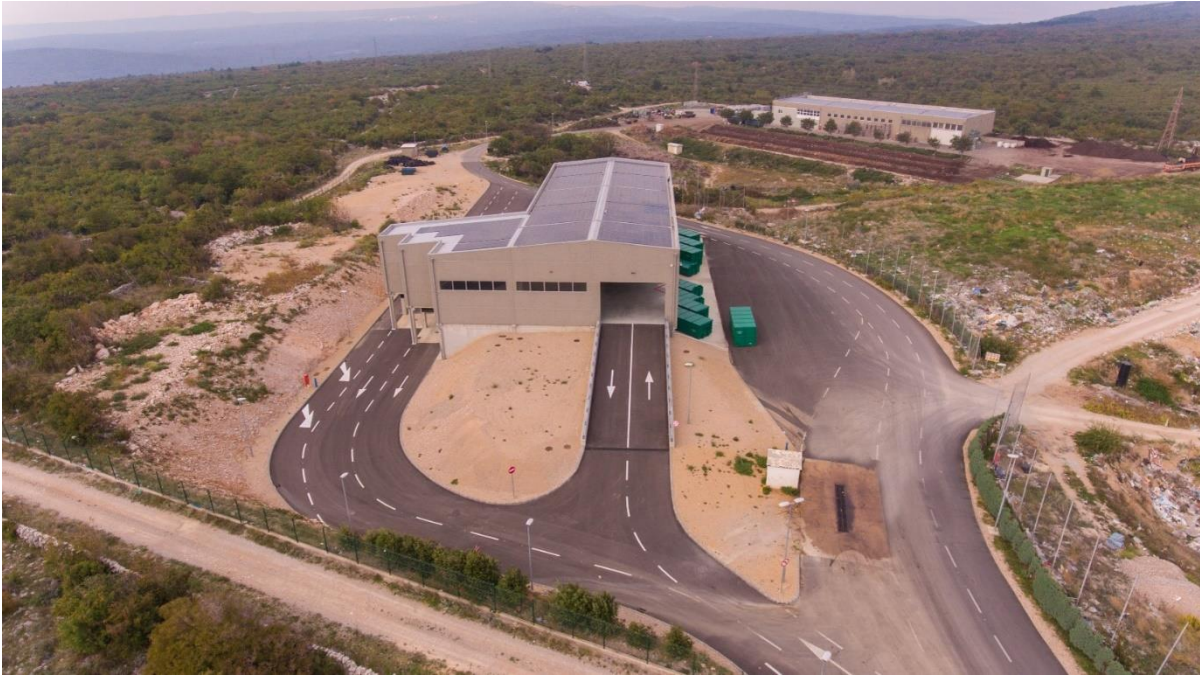
Slika 4.: Pretovarna stanica na Treskavcu
