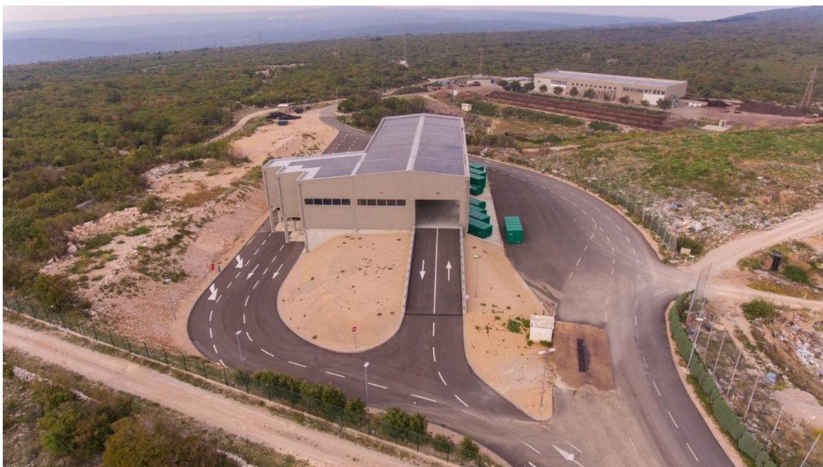
Slika 4.: Pretovarna stanica na Treskavcu
