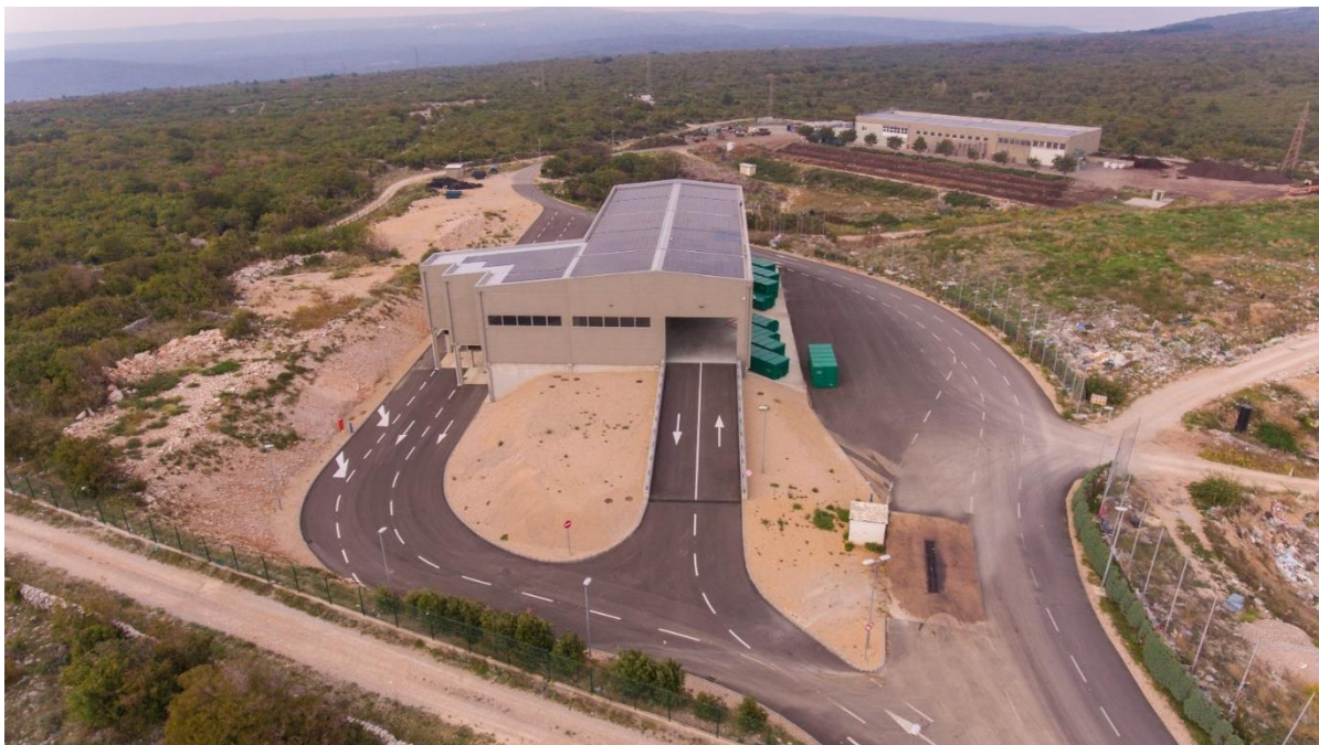
Slika 4.: Pretovarna stanica na Treskavcu
